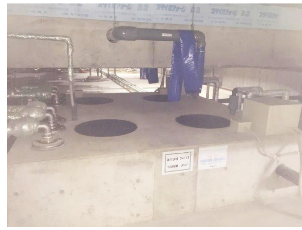
水: 貯水槽: 3日分 上水 15t*2槽 (30t) 雑用水 35t*2槽 (70t)
