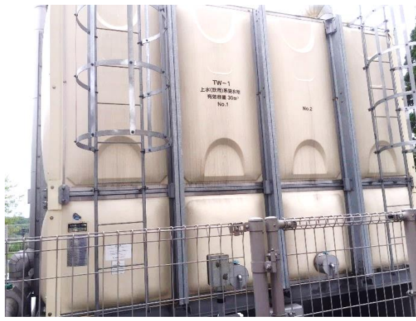
水: 貯水槽: 3日分 上水 15t*2槽 (30t) 雑用水 35t*2槽 (70t)
